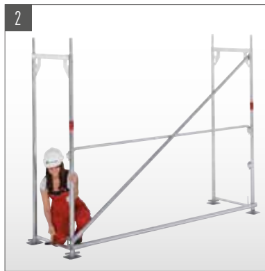
2 Vertikaldiagonale montieren, Horizontalstrebe einbauen (nur im Diagonalfeld).
