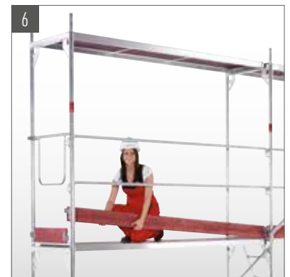
6 Stellrahmen und Beläge der nächsten Lage montieren, Diagonale, Geländer und Bordbretter einhängen.
